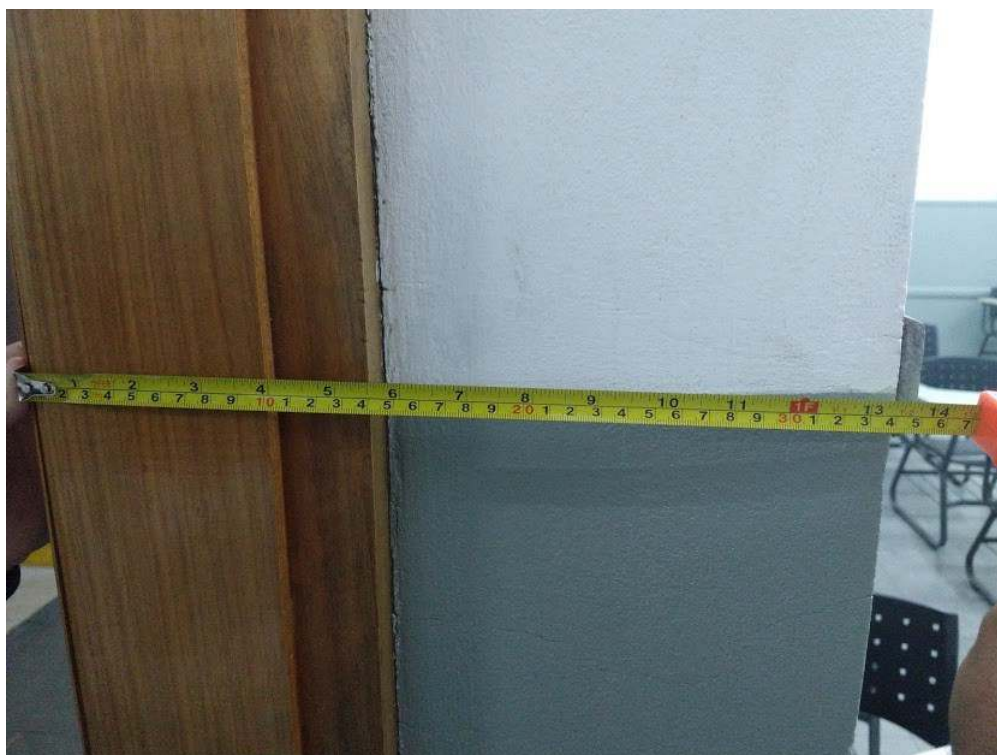
Figura 14 – Parede do Prédio Principal
